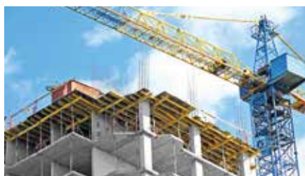
建設現場 ▶ 安全点検
